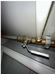
Manglende tettemuffer på vannrør
