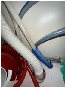
Manglende tettemuffer på vannrør
