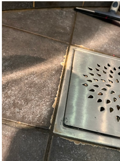
Skader på fliser rundt sluk
