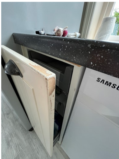
høy grad av slitasje på innredning
