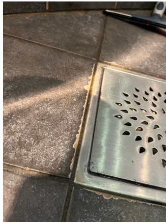
Skader på fliser rundt sluk
