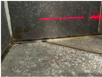
Silikon har sluppet enkelte plasser, svertesopp i silikon.
