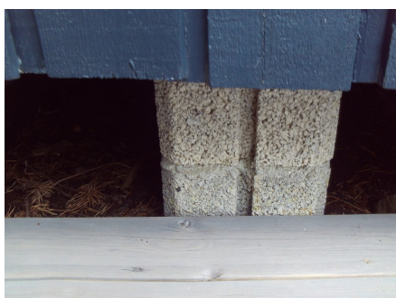
Pillarer på tilbygget deler.
