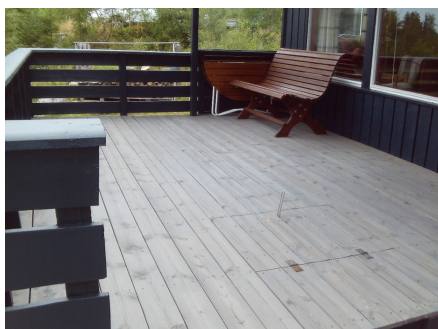
Deler av terrasse ut i fra stue
