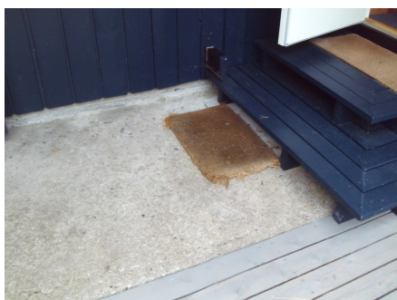
Støpt platting ved inngangsparti
