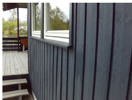
Deler av kledningen med tilhørende belistninger
