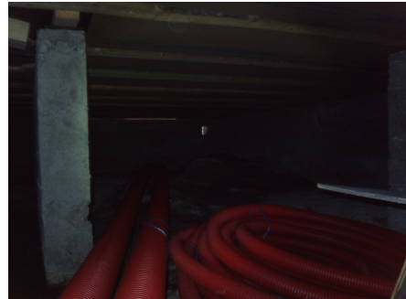
Deler av krypkjeller
