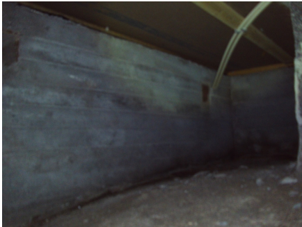
Bra med ventiler i ringmur.
