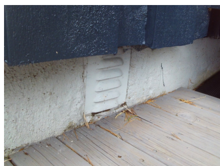
Deler av støpt ringmur.
