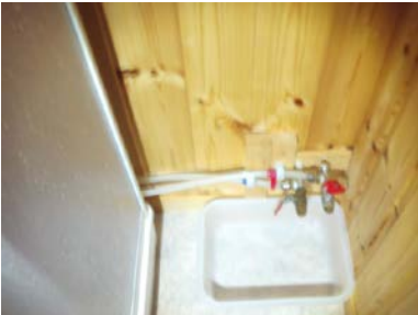
Plastrør på dusjrom.
