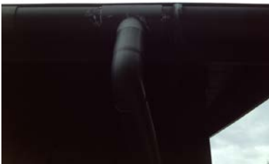
Deler av takrenner.
