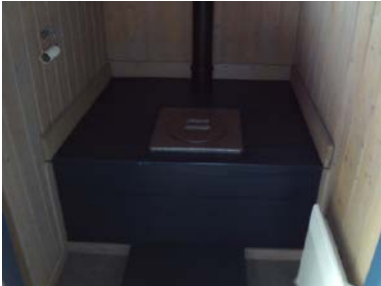
Deler av toalettrom.
