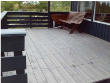
Deler av terrasse ut i fra stue
