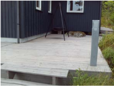
Platting på flere nivåer.
