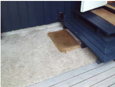
Støpt platting ved inngangsparti
