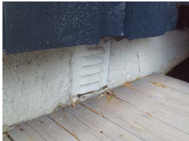
Deler av støpt ringmur.
