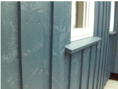
Deler av fasade som er kledd på nytt.
