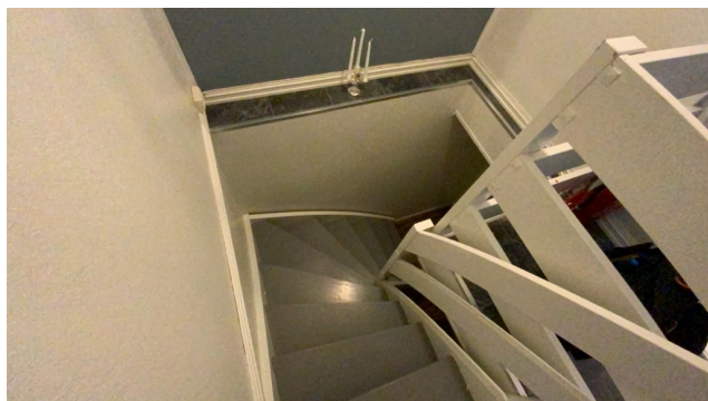
Besiktigelse av trapp.
