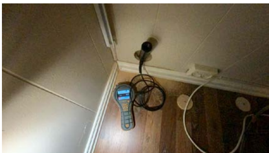
Utført hulltaking på rom under terreng.
