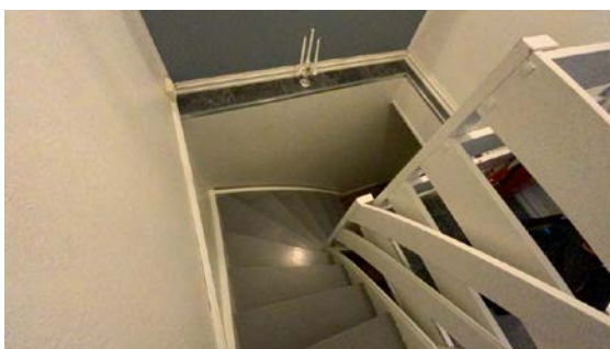
Besiktigelse av trapp.
