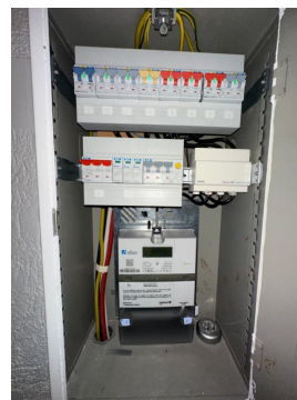
Sikringsskap med automatsikringer.
