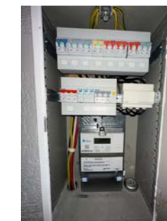
Sikringsskap med automatsikringer.
