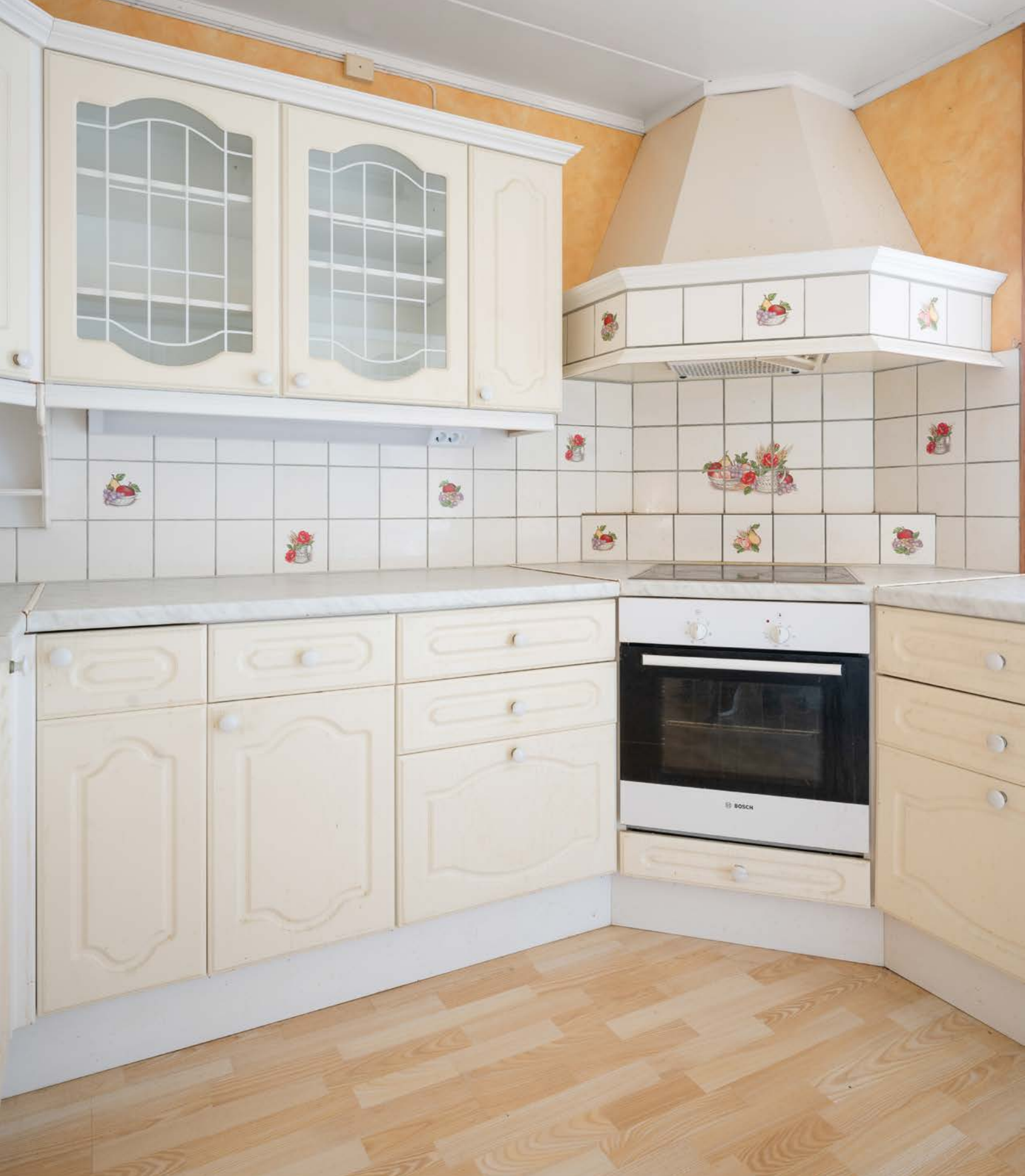
Kjøkkenventilator med avtrekk ut
