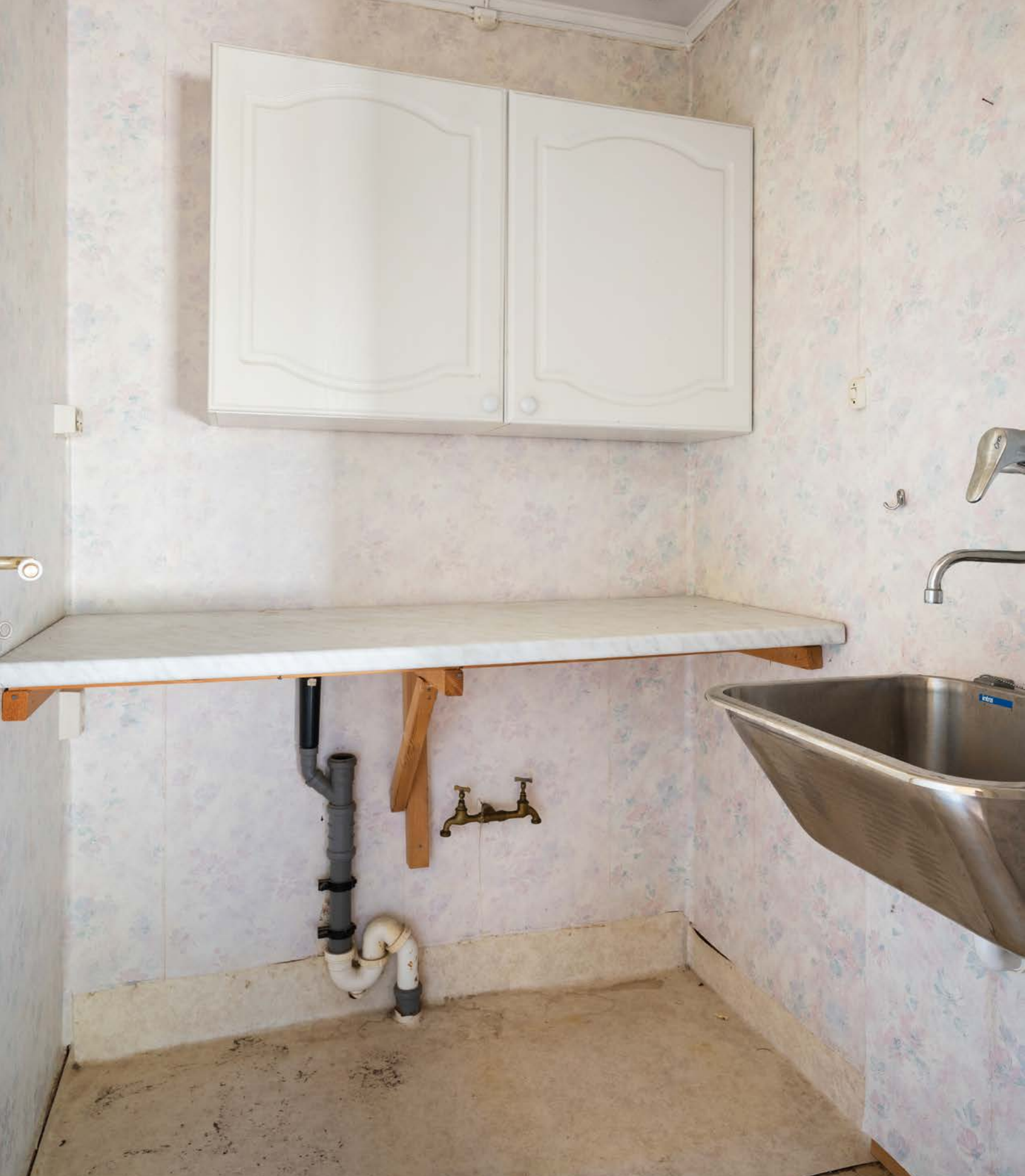
Vaskerommet har utslagsvask og opplegg for vaskemaskin
