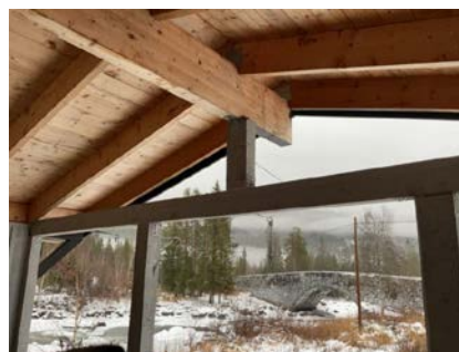
Snø/taktyngde bør ettersees vinterstid, utførelse av konstruksjoner er fagmessig.
