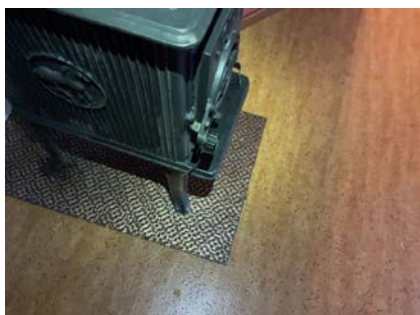
For liten plate på gulv under ildsted
