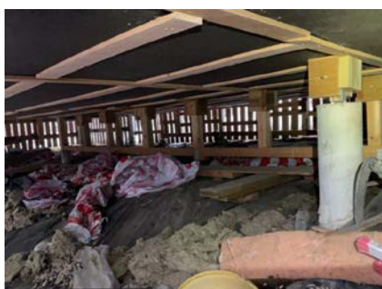
Tilbyggets fundamentering utført med egeninnsats spenn/bæring bær gjennomgåes
