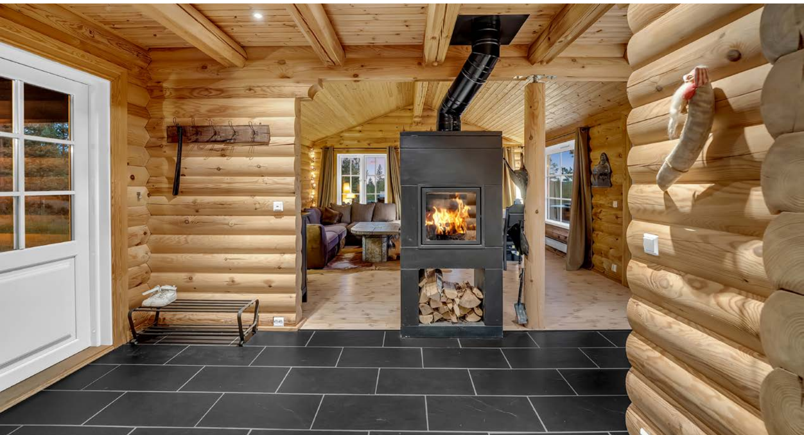
Peisovnen i overgangen entre/stue gir effektiv oppvarming kombinert med elektrisk gulvvarme.
