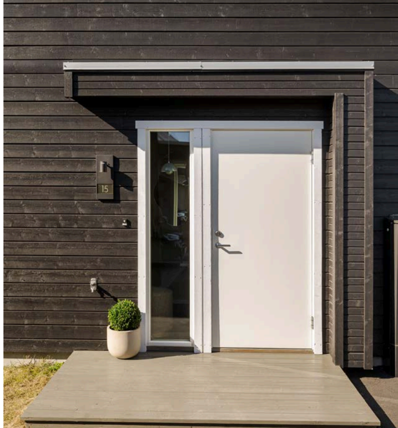
Inngangsparti med plattning og lite overbygg. Praktisk vindu ved siden av inngangsdør.
