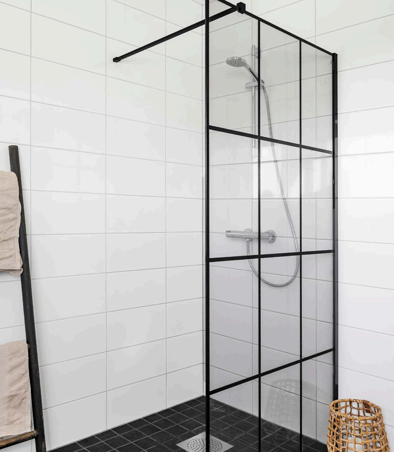
Dusjnise med glassvegg og vegghengt armatur gir en praktisk løsning i badet.
