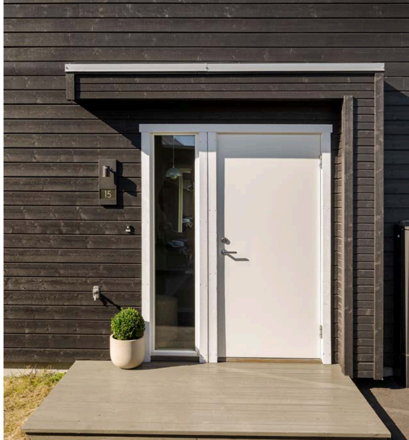
Inngangsparti med platting og lite overbygg. Praktisk vindu ved siden av inngangsdør.
