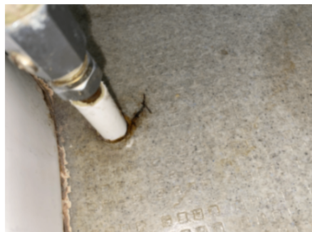
Revnet vinylbelegg inntil toalett.
