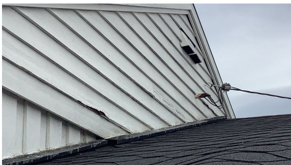
Råteskadet bordkledning.
