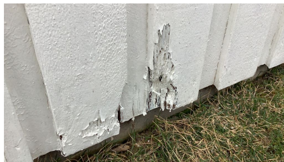
Råteskadet bordkledning.
