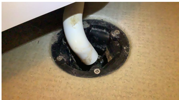
Plastsluk, og vinylbelegg er ført under slukets klemring.
