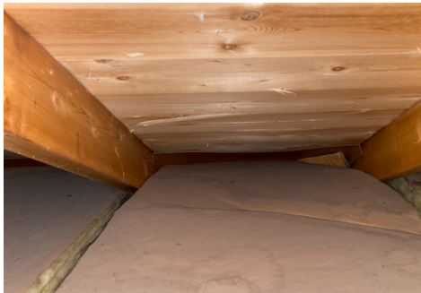
Raftepapp stenger stedvis for luftingen.
