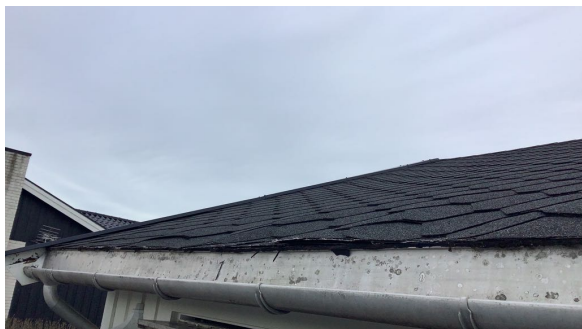
Svanker i taket mellom takstoler.
