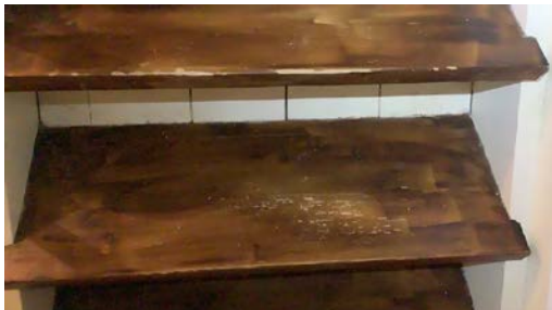
Eksempel på slitasje i trinn.
