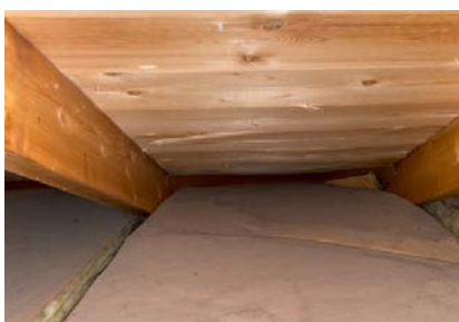
Raftepapp stenger stedvis for luftingen.
