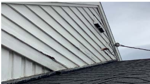
Råteskadet bordkledning.
