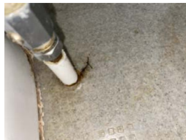
Revnet vinylbelegg inntil toalett.
