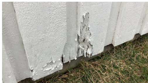
Råteskadet bordkledning.
