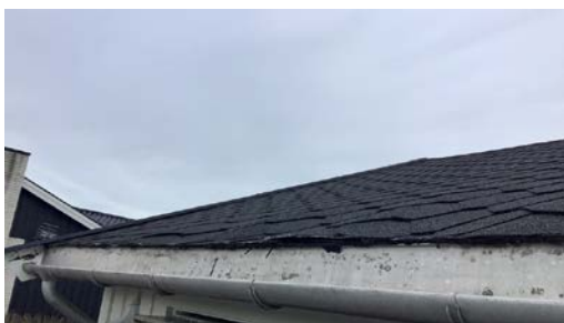
Svanker i taket mellom takstoler.
