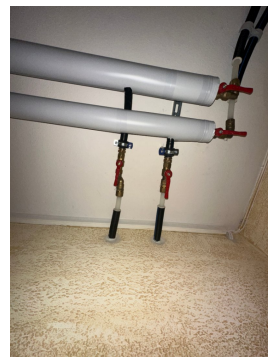
Stoppekraner plassert i felles gang
