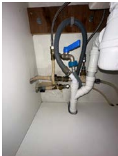
Røropplegg under servant på bad
