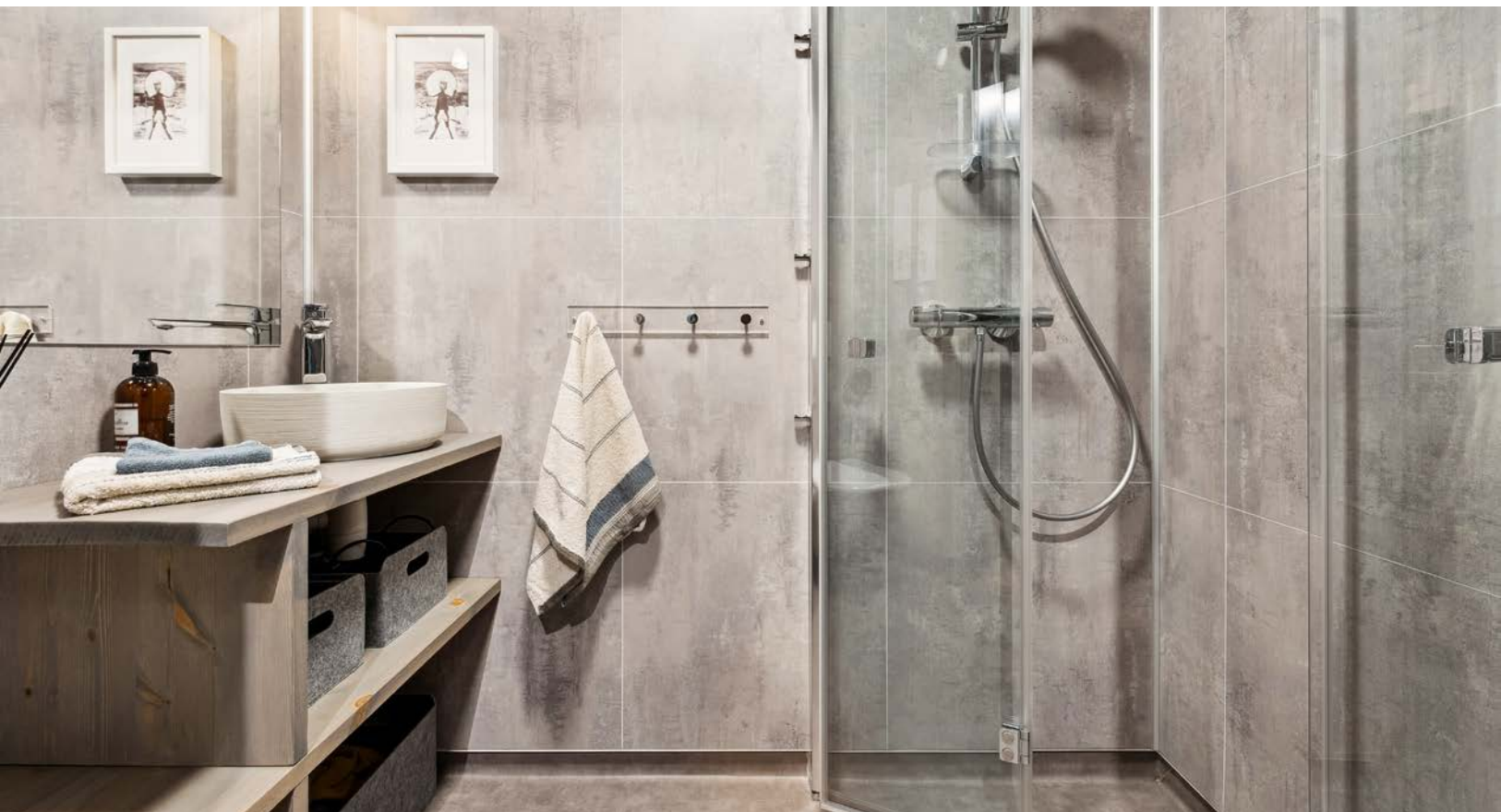
Badet ble renoveret i 2020
