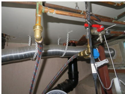
Avtrekkskanal fra bad ført til yttervegg.
