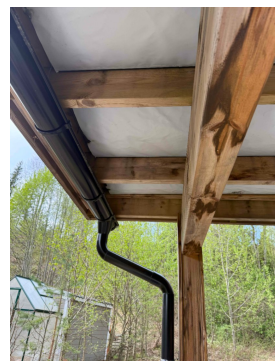
Bildet viser avslutning på undertaksduk mot takrenne
