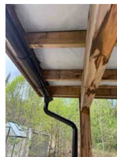
Bildet viser avslutning på undertaksduk mot takrenne
