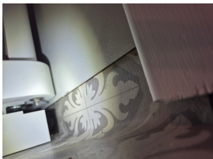
Mangler aluminiumslist i bunn av våtromsplate.
