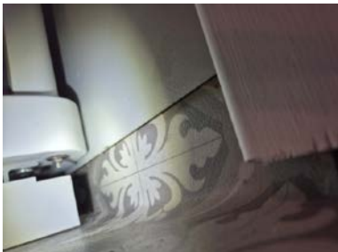
Mangler aluminiumslist i bunn av våtromsplate.
