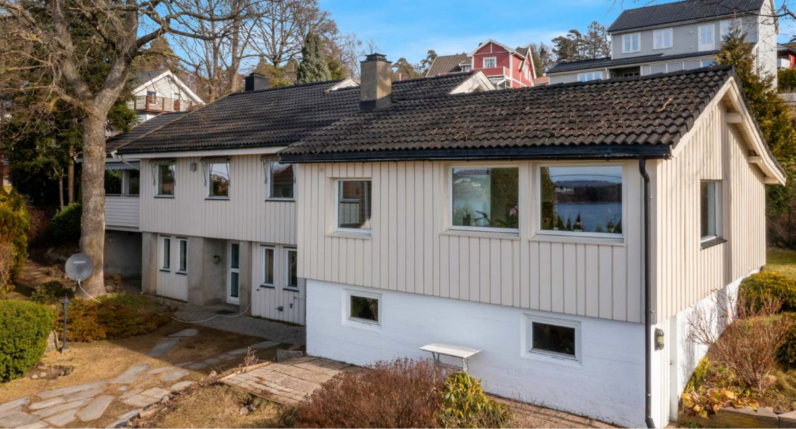
Den eldste delen (nærmest Bakkeveien) ble bygget i 1946. Den største delen ble bygget i 1983
