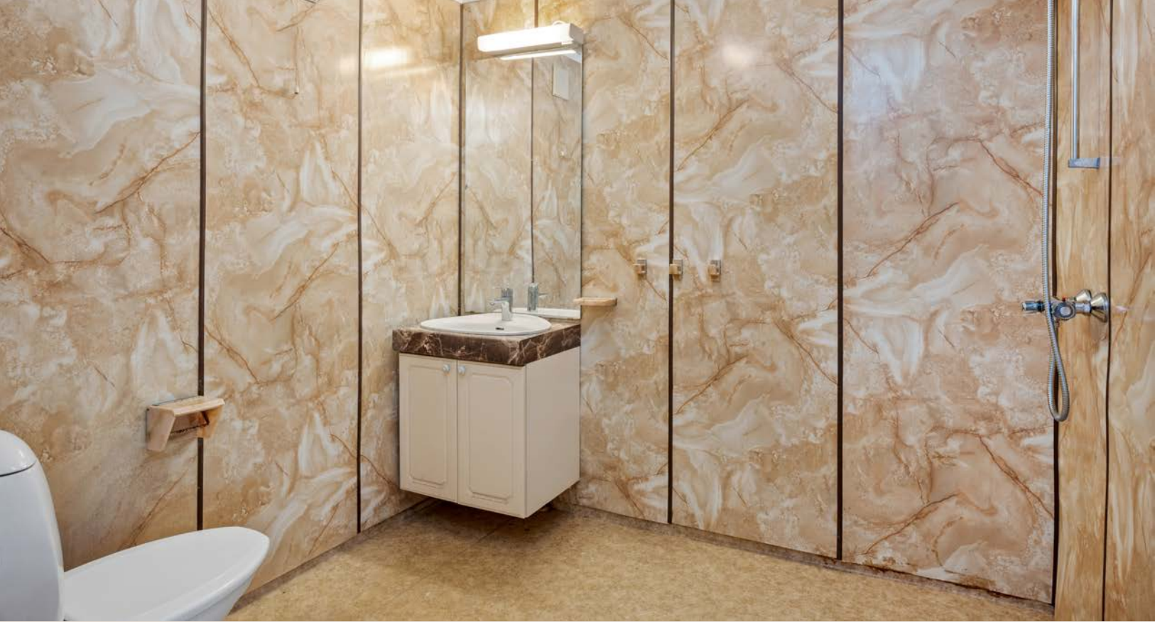
Baderom fra byggeår
