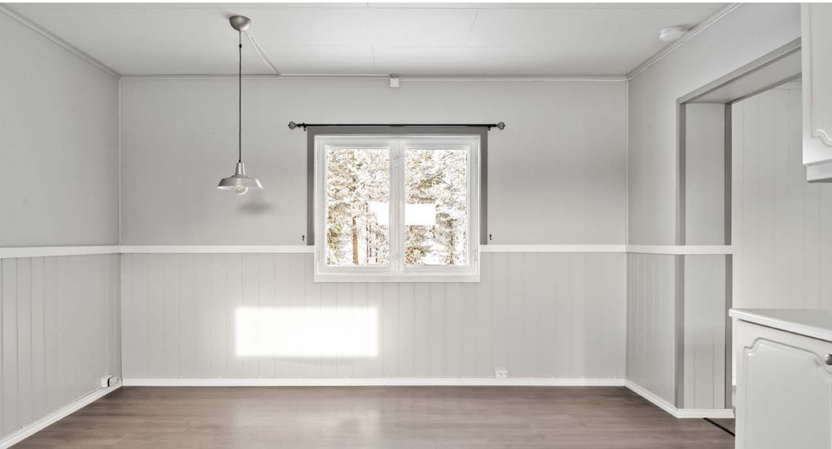
Boligen har vinduer med varierende årstall. Det ble påvist vinduer fra 2020 og 1995. Øvrige vinduer har ukjent årstall.
