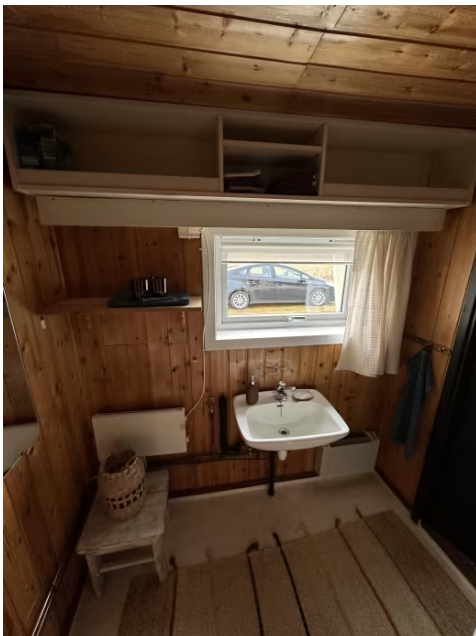
Viser vegghengt servant med 1-greps blandebatteri.
