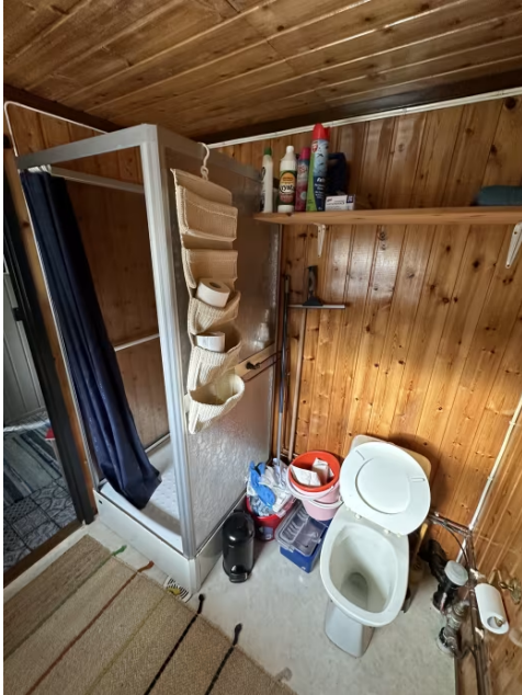
Viser dusjkabinett og gulvstående toalett.
