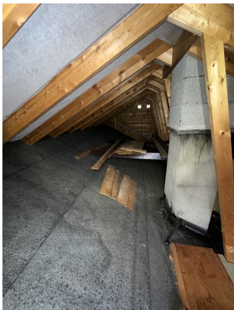
Viser loft ved tilbygget del.
