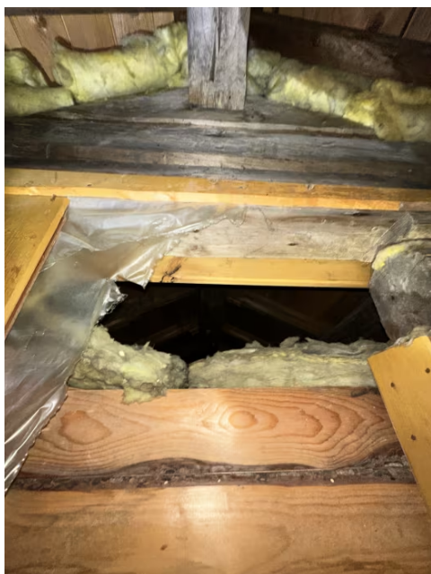
Viser adkomst til loft over stuedel.
