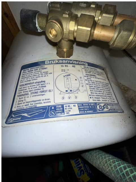
Viser teknisk data på bereder.
