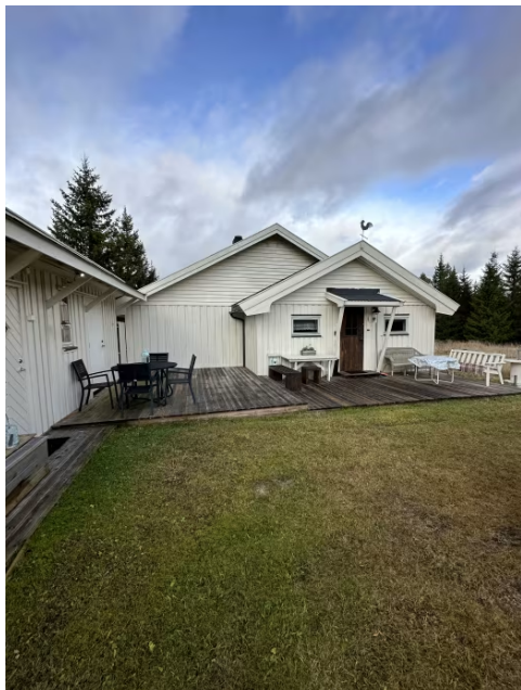
Viser terrasse og markterrasse.
