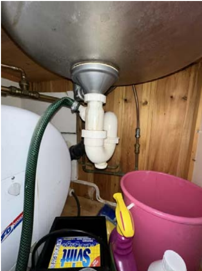
Viser vann og avløpsinstallasjoner under kum.
