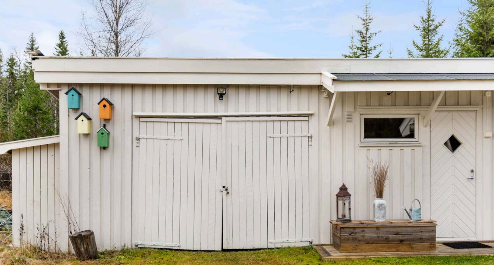
Uisolert garasje med grus som underlag og 2-delt sidehengslet dører.
