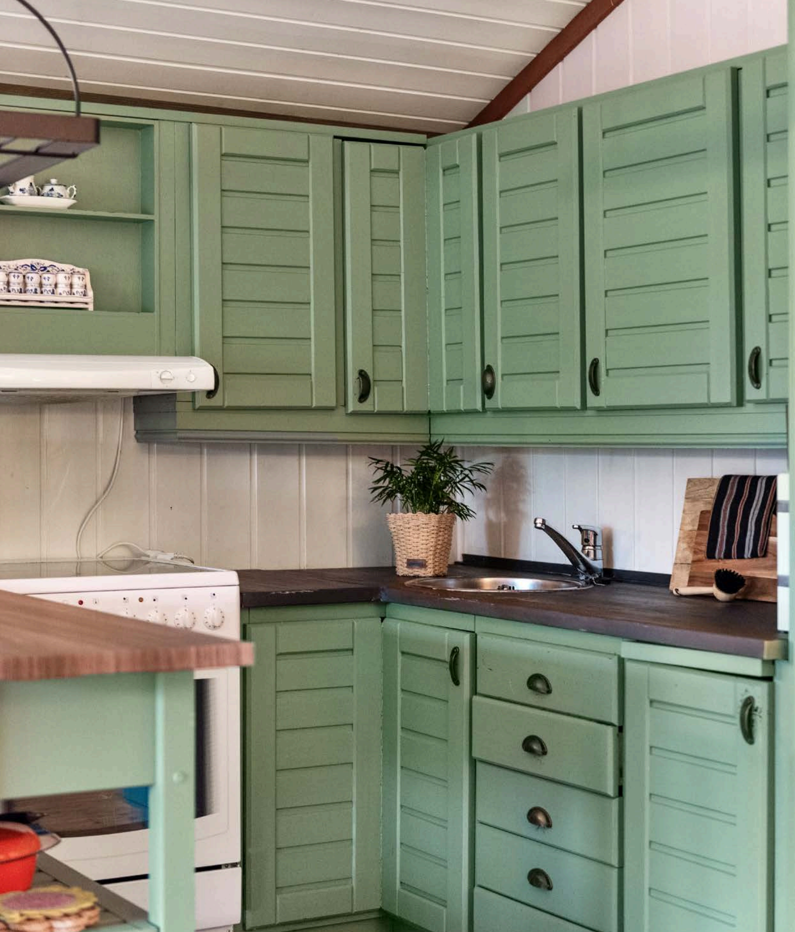
Innredningen har malte profilerte fronter og heltre benkeplate med nedfelt oppvaskkum.
