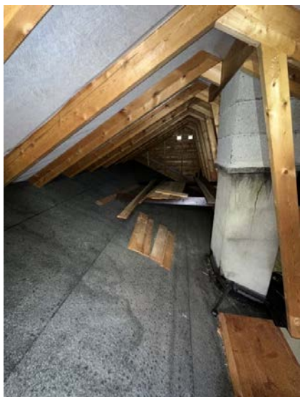
Viser loft ved tilbygget del.
