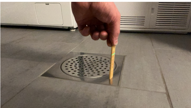
Måler 64mm på sluk ved vaskemaskin.
