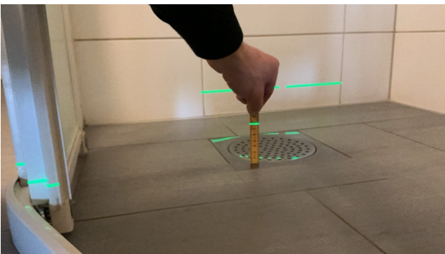
Måler 69mm på sluk i dusj
