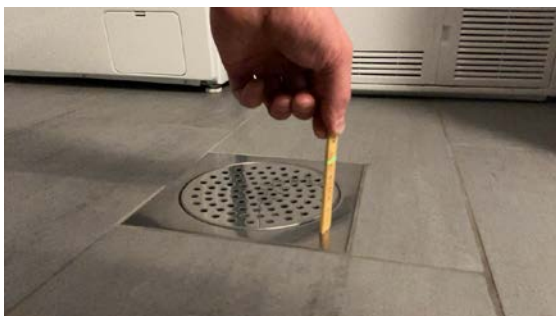
Måler 64mm på sluk ved vaskemaskin.
