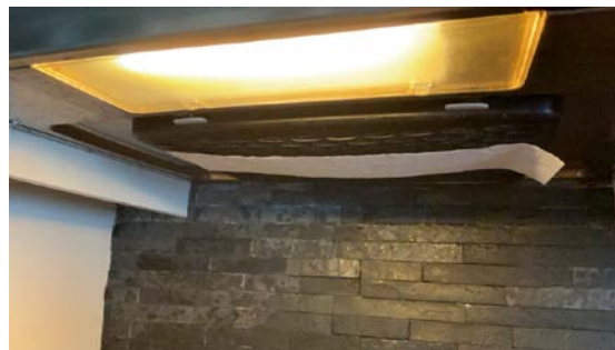
Bilde viser funksjonstest av avtrekk
