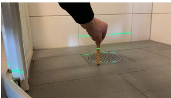
Måler 69mm på sluk i dusj
