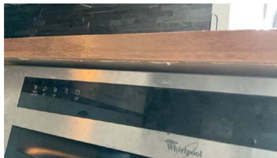
Slitasje av fukt på benkeplate.
