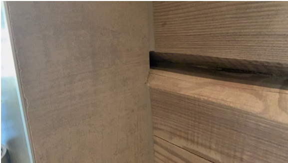
Glipper der hvor fliser møter tømmer.
