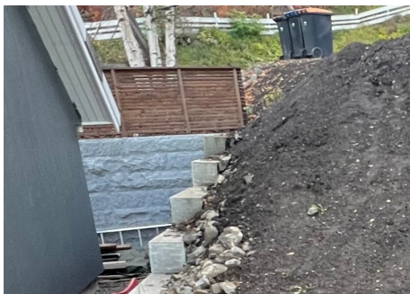
Støttemur mot naboen på nordsiden.
