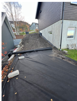
Pågående arrondering ved gavlvegg.
