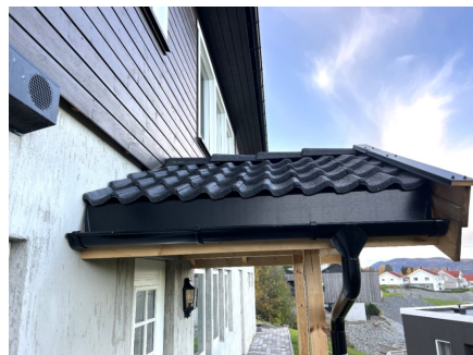
Tak ved inngang. Ikke beslag tak/vegg.
