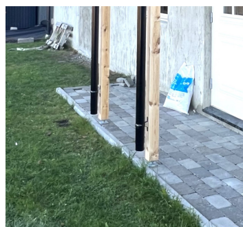
Tak ved inngang. Ikke beslag tak/vegg.
