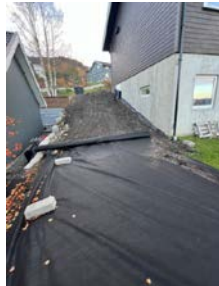
Pågående arrondering ved gavlvegg.
