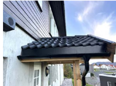
Tak ved inngang. Ikke beslag tak/vegg.
