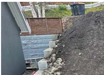
Støttemur mot naboen på nordsiden.
