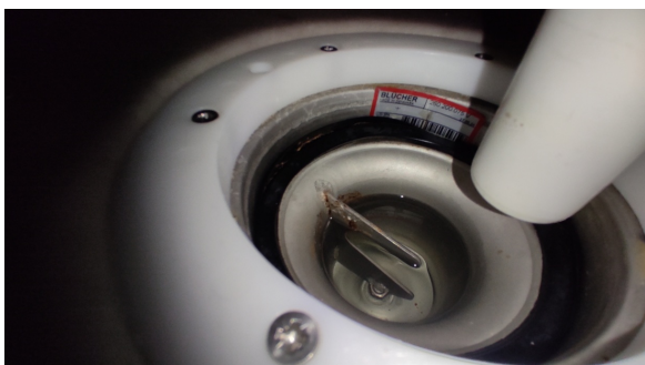
Kontroll av sluk.
