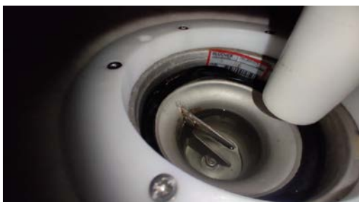
Kontroll av sluk.
