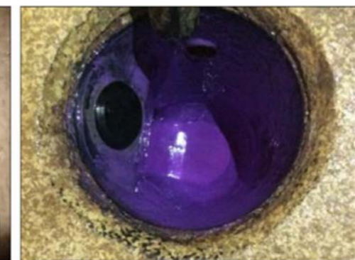
Fig. 17: Sluk med ny vannlås, behandlet med epoksy. Kilde: Leverandør 1
