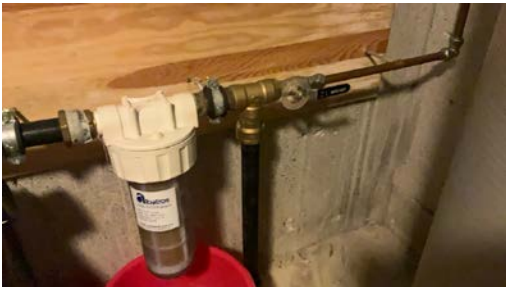
Innvendig hovedstoppekran er plassert i kjeller. Filter for vann fra borehull.
