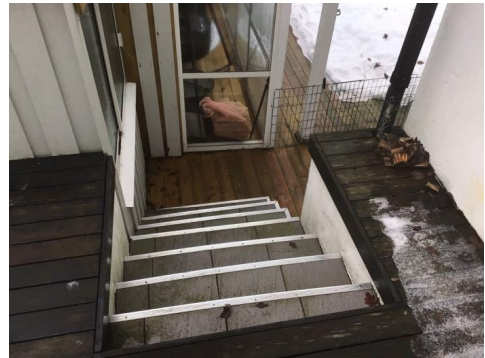
Mangler rekkverk
