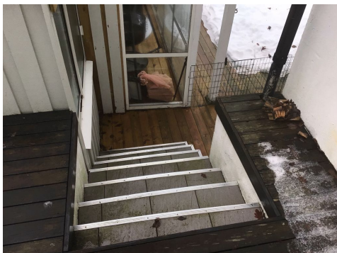
Mangler rekkverk
