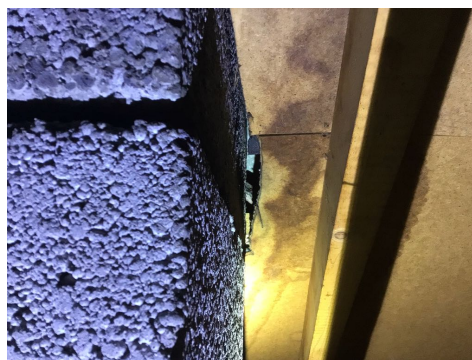
Utettheter langs pipe
