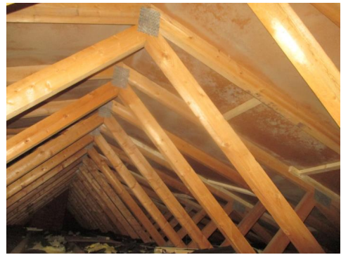
Deler av takkonstruksjonen.
