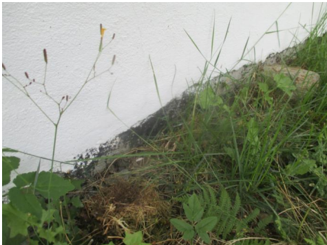
Eldre opprinnelig fuktsikring av grunnmur.
