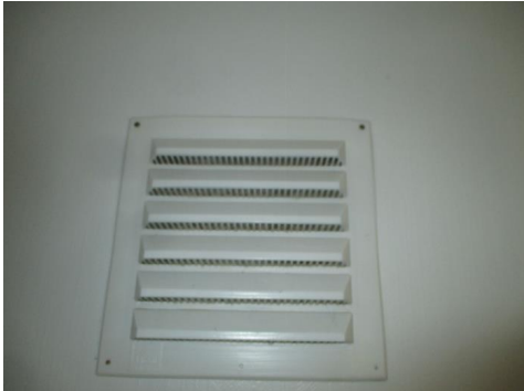
Ventil i grunnmur.
