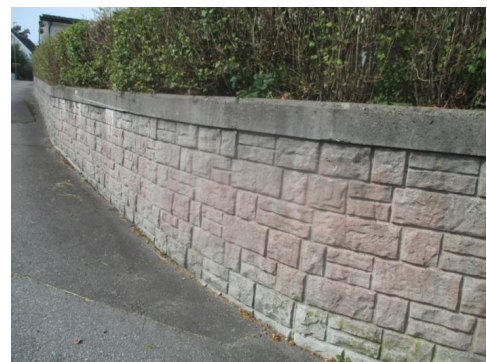
Forstøtningsmur i mot vei.
