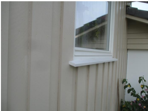
Deler av kledningen med tilhørende belistninger.
