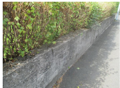
Støpt mur i mot vei.
