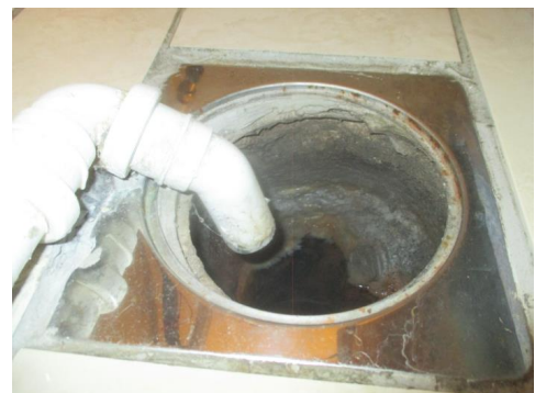
Eldre sluk i gulvet.
