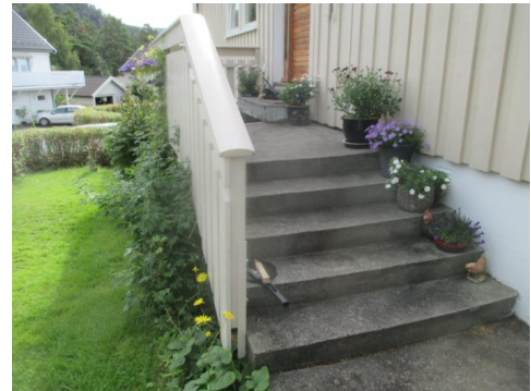
Støpt trapp med repos til inngangsparti.
