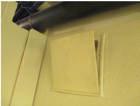
Ventil i grunnmur.
