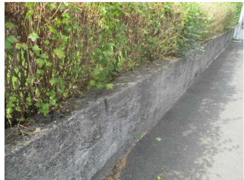
Støpt mur i mot vei.
