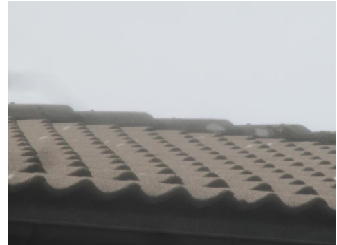
Selve taksteinen har normal slitasje ut i fra alder.
