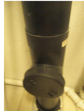
Avløpsrør av plast med stakeluke.
