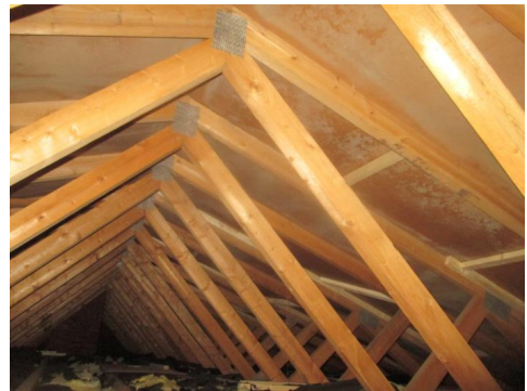
Deler av takkonstruksjonen.
