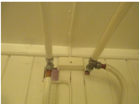
Noe eldre kobberrør.
