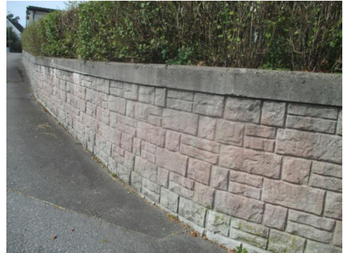
Forstøtningsmur i mot vei.
