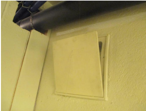
Ventil i grunnmur.
