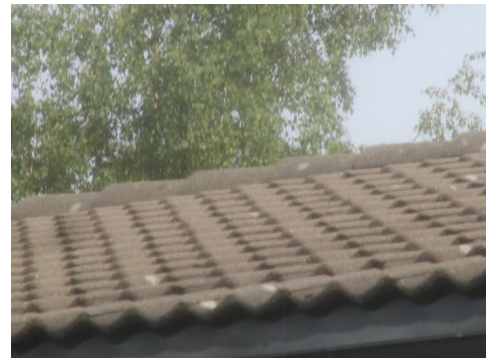
Deler av taktekkingen.
