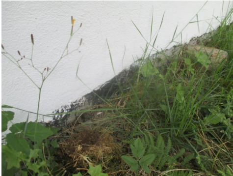
Eldre opprinnelig fuktsikring av grunnmur.
