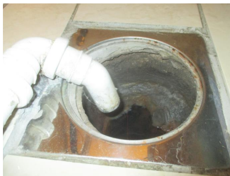
Eldre sluk i gulvet.
