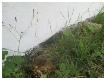
Eldre opprinnelig fuksikring av grunnmur.
