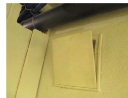
Ventil i grunnmur.
