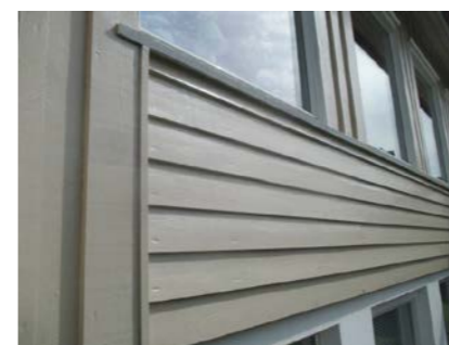
En del kledning er blitt byttet i samband med skifting av vinduer.
