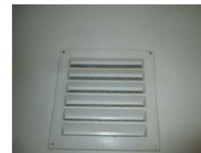
Ventil i grunnmur.
