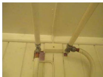
Noe eldre kobberrør.
