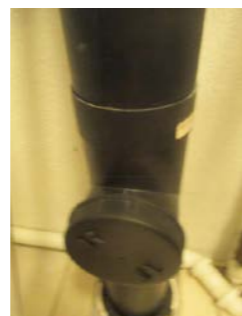
Avløpsrør av plast med stakeluke.
