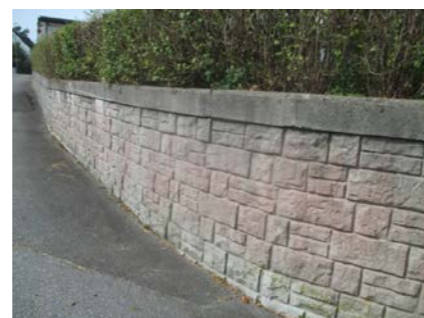
Forstøtningsmur i mot vei.
