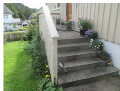
Støpt trapp med repos til inngangsparti.
