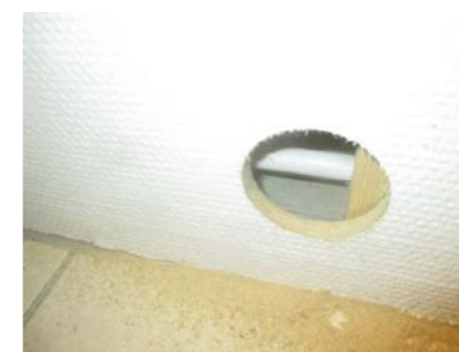
Hulltaking i skillevegg i mot bad.
