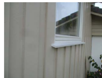
Deler av kledningen med tilhørende belistninger.
