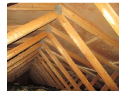
Deler av takkonstruksjonen.
