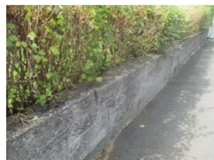
Støpt mur i mot vei.
