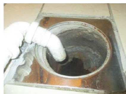
Eldre sluk i gulvet.
