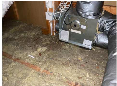
Flexit avtrekk montert på loftet
