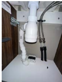
Røropplegg på wc med Waterguard
