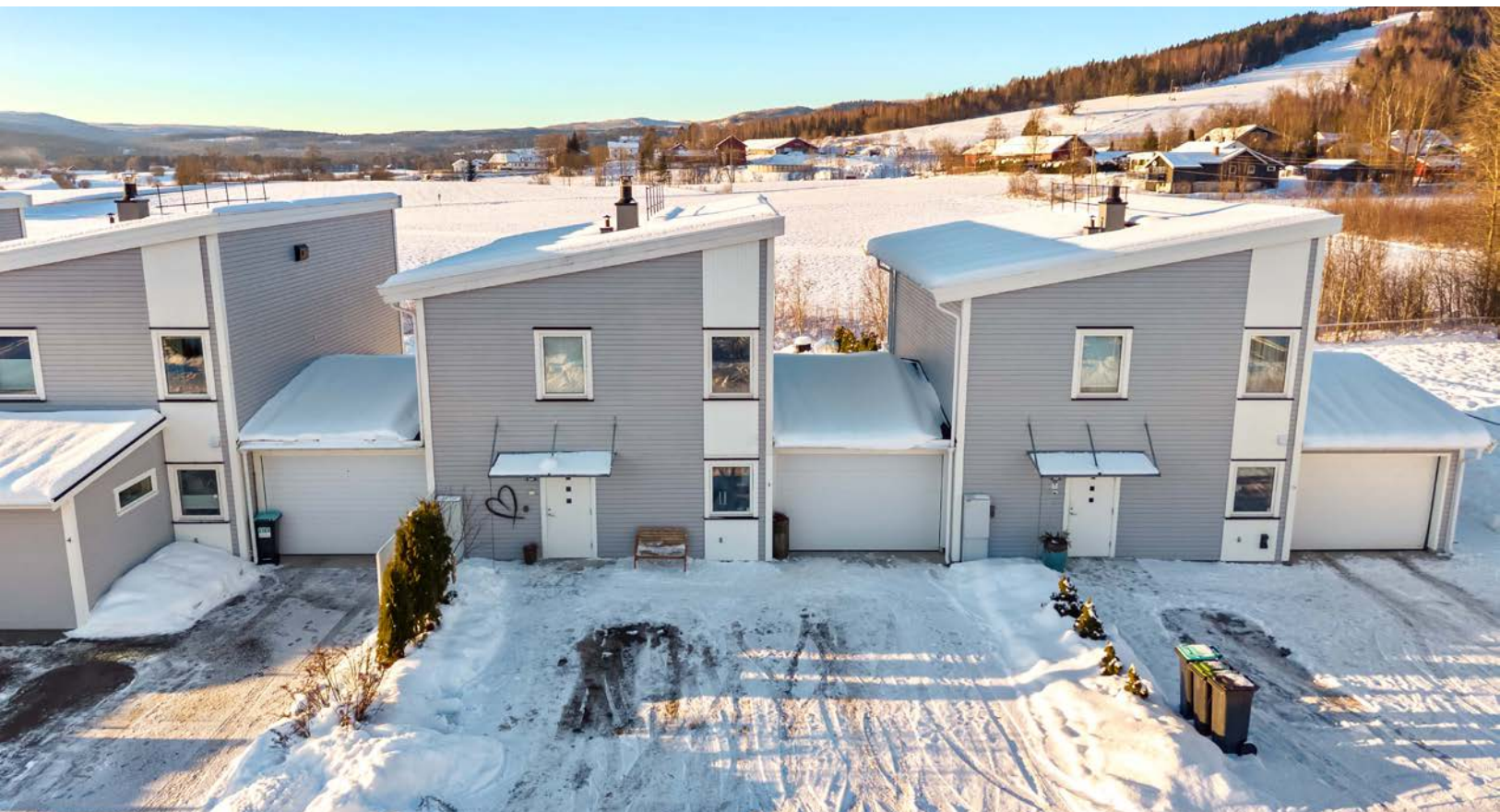
Det følger garasje til boligen i fremkant ved inngangsparti. Det er også parkeringsmuligheter foran denne.
