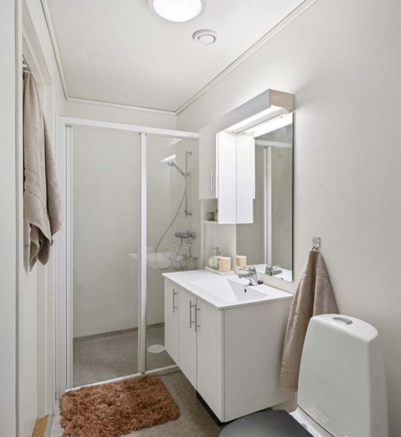
Belegg på gulv og våtromstapet på vegger.
