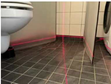
Fall på baderomsgulv er kontrollert med krysslaser.
