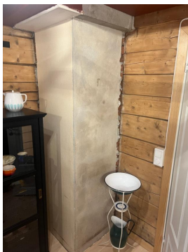
ikke montert ildfast plate under/foran ovn
