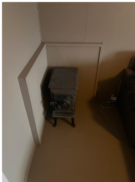
ikke montert ildfast plate under/foran ovn
