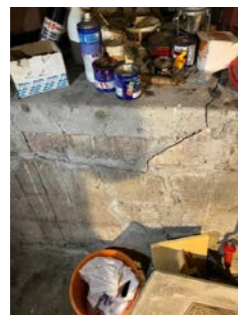
Sprekker i grunnmur i rom med utgang til terreng
