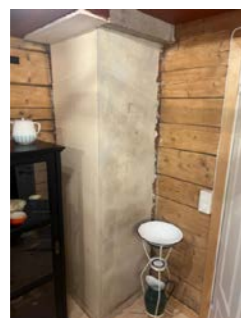
ikke montert ildfast plate under/foran ovn
