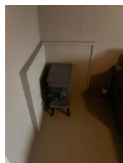
ikke montert ildfast plate under/foran ovn
